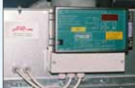
Styrepanel indstiller frekvens og efterrensning.
