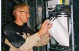
Nem adgang til filterskift gennem let aftagelig inspektionslem.
